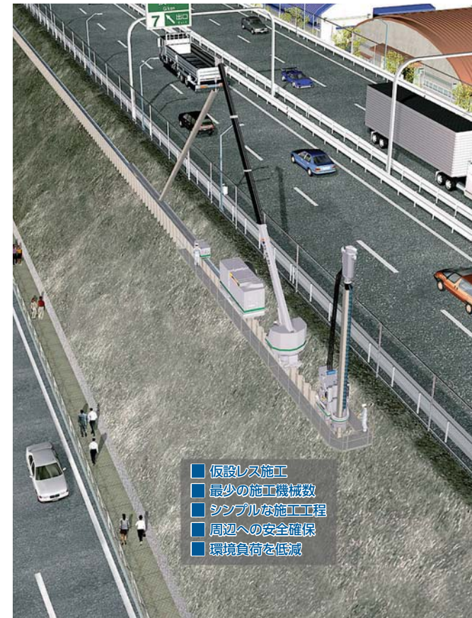
硬質地盤クリア工法の適用例
