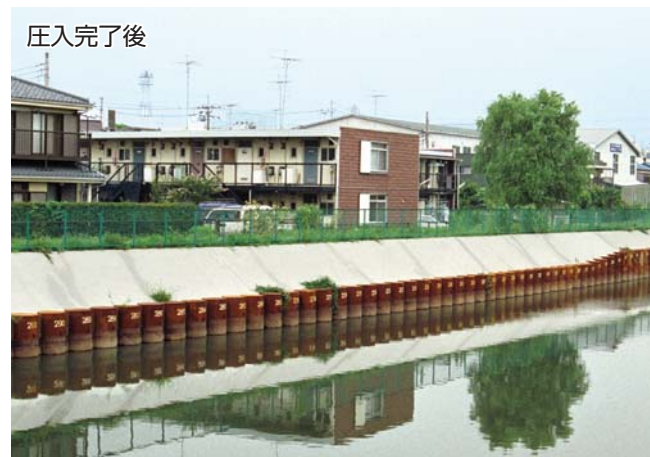
地球と杭が一体となったインプラント構造の護岸を仮設レス施工で構築
