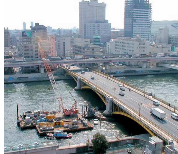
橋脚基礎耐震補強工事
