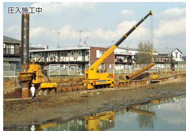
地球と杭が一体となったインプラント構造の護岸を仮設レス施工で構築
